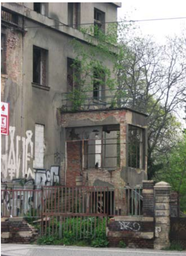
Detail jednoho z domů – vlastní vily významného architekta Kamila Roškota z roku 1928
