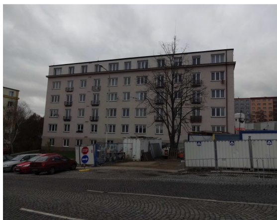
Obytná zástavba v ulici Liberijská
