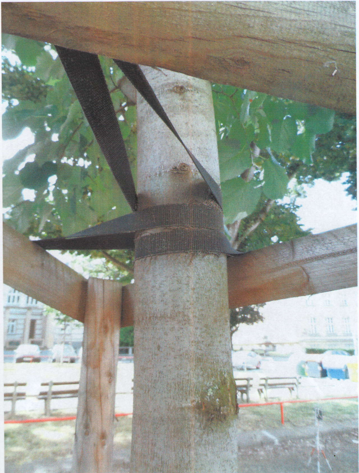
Foto č. 6: Detailní pohled na neuvolněný stabilizační popruh, který již poškozuje kmínek mladé výsadby.
