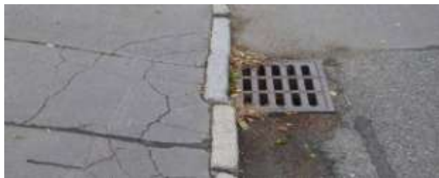
Prostor při vyústění ulic Na Marně a Ch. de Gaulla s parkováním... Detail - kamenný obrubník, uliční vpust a rozpukaný chodník
