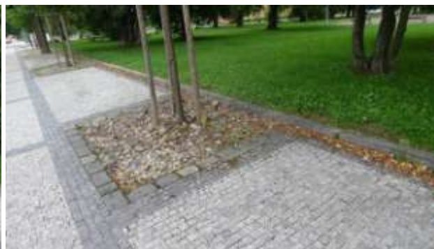
Chodník u Terronské – kamenná dlažba žula, D5 ...Detail – řezaná, světlá a šedá, obrubník štípaný tl. 10, rabátka kostky D10/15
