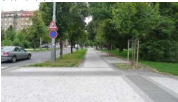
Chodník u Terronské – kamenná dlažba žula, D5 ...Detail – řezaná, světlá a šedá, obrubník štípaný tl. 10, rabátka kostky D10/15
