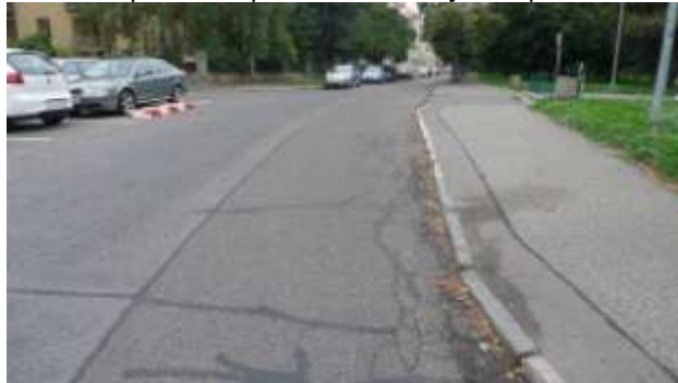
Ulice s úzkými chodníky, obrubník na straně parku z kamenných kostek D15, dále z kamenných obrubníků o šíři 10 cm
