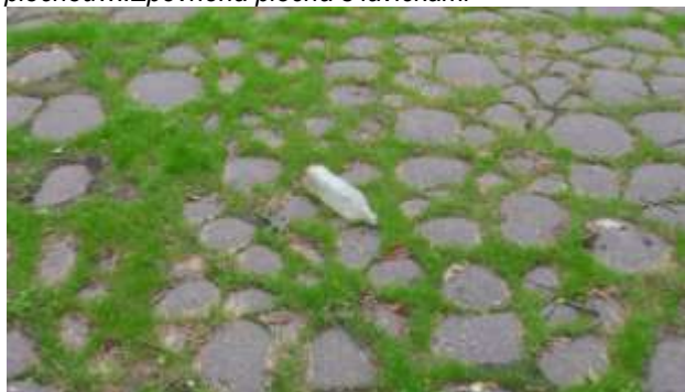
Střední široká zpev. plocha – pohled od jihu k ZŠ.....Detail kvality plochy ve střední části – rozpukané a prorůstající
