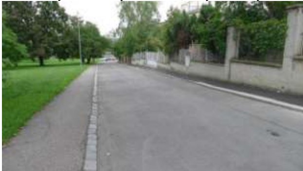
Ulice s úzkými chodníky, obrubník na straně parku z kamenných kostek D15, dále z kamenných obrubníků o šíři 10 cm
